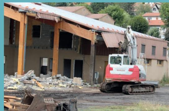
Ce chantier phare a débuté le 17 septembre 2020 : l'entreprise Orfeuvre a commencé le terrassement et procédé au retrait du bardage des murs. La société Pyramid a quant à elle réalisé des fondations spéciales comprenant 38 forages de 8 à 9 mètres de profondeur pour les pieux d'ancrage.
